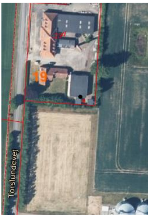
Solcelletrackere placeret ved sydligt skel (rød prik)
